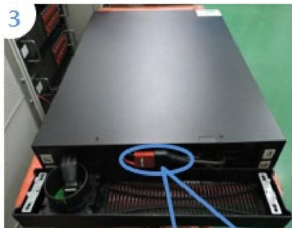
Verriegeln Sie das Batteriekabel
