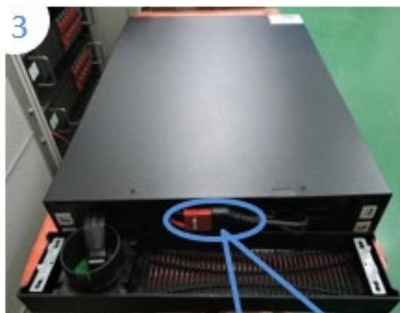
Verriegeln Sie das Batteriekabel
