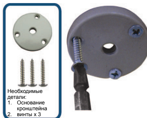
Рис. 2: Крепление основания к потолку с помощью винтов
